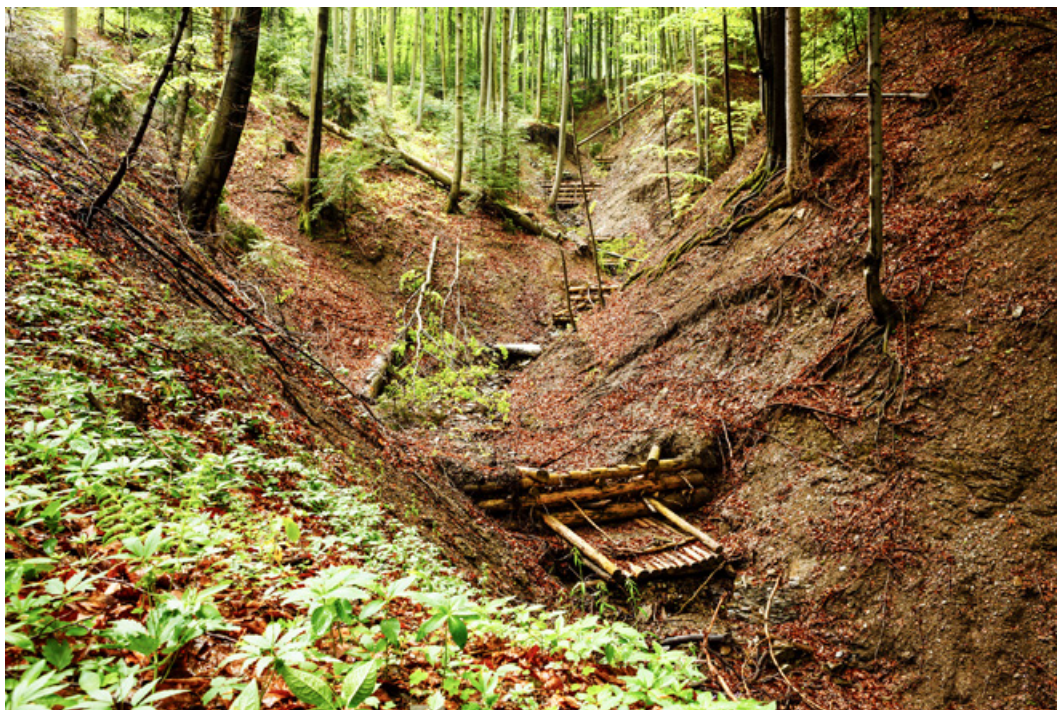
Fot. 149. Niewielkie zapory przeciwrumowiskowe rozłożone w wyerodowanym wąwozie na ciekі okresowym, Nadleśnictwo Limanowa (archiwum CKPŚ)
